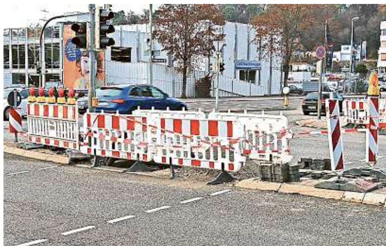
An der Karlsruher Straße werden Leitungen für neue Blitzer verlegt. FOTO: WOLF
